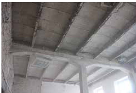
Stropy trzeba było wymienić, ponieważ dyktowała to ekspertyza techniczna – strop nie nadawał się do użytkowania
