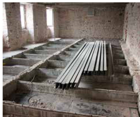
Strop po demontażu
